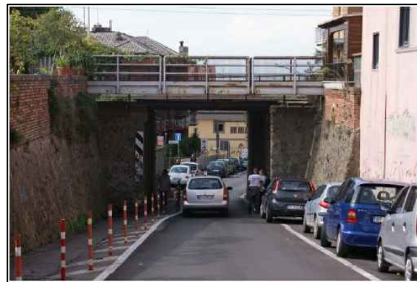
FOTO 1_ Sottopasso via Vascarelle, vista da monte
