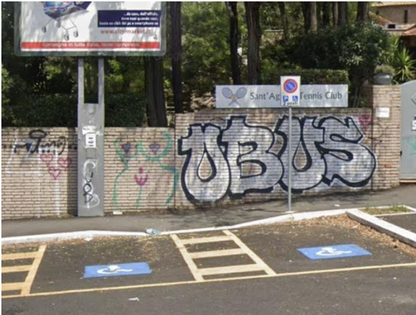
Rampe disabili in corrispondenza posto auto disabili, per sottrazione – Piazza di Santa Costanza (Roma)
