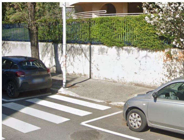
Rampe di raccordo tra marciapiede e sede stradale, in asfalto - Via Cucchini (Roma)
