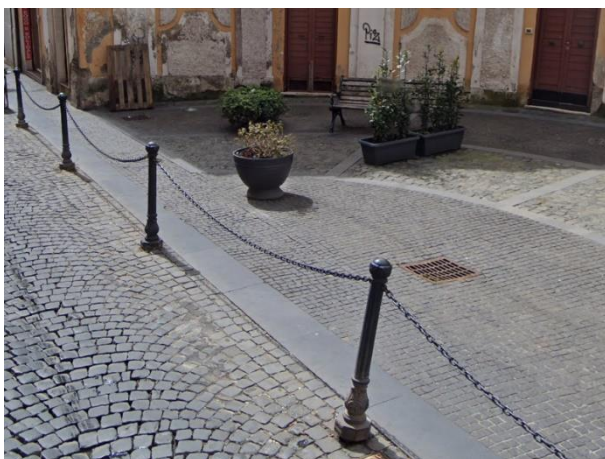
Protezione di percorso pedonale a raso (Parigina) – Via Alcide De Gasperi (Albano Laziale)
