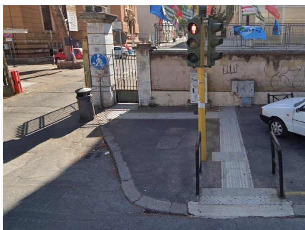
Segnali tattili di ingresso ad un edificio – Viale Regina Elena (Roma)
