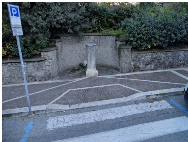
Rampe di raccordo tra marciapiede e sede stradale, in porfido - Borgo Garibaldi (Albano Laziale)
