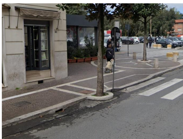
Realizzazione nuovo marciapiede in porfido – Corso G. Matteotti (Albano Laziale)
