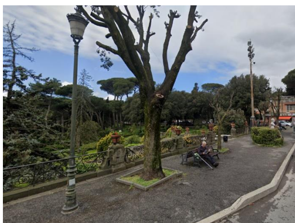
Realizzazione nuovo marciapiede in asfalto – Via Cardinal Altieri (Albano Laziale)
