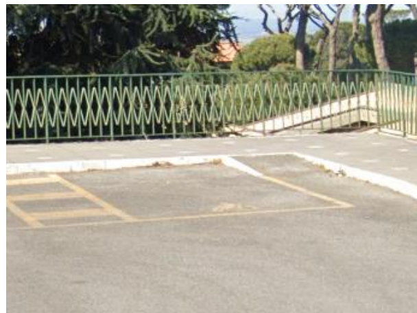
Rampe disabili in corrispondenza posto auto disabili, aggiunta – Viale S. G. Battista de la Salle (Castel Gandolfo)
