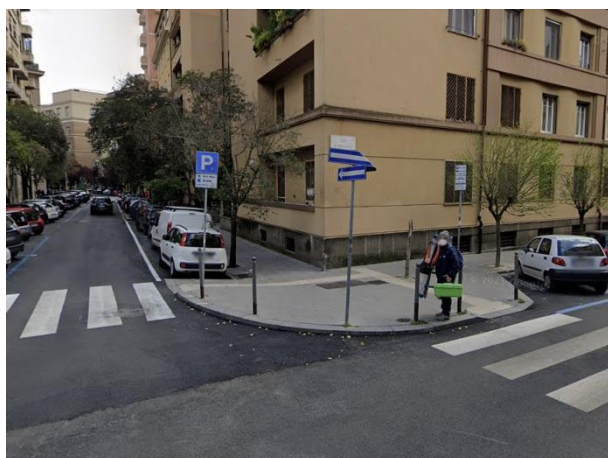
Allargamento del marciapiede – Via Reggio Calabria (Roma)
