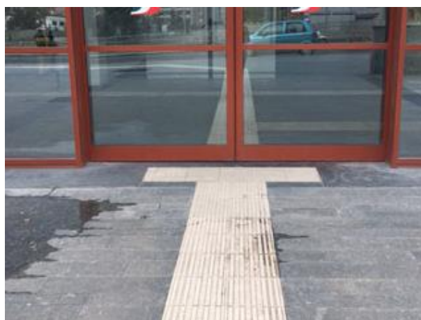
Segnali tattili di ingresso ad un edificio, Stazione ferroviaria di Imperia
