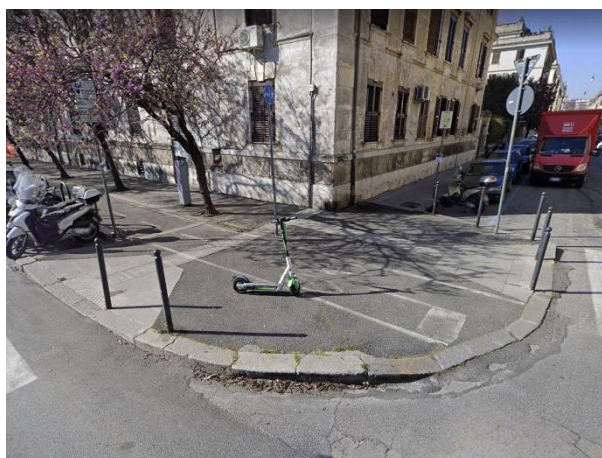
Allargamento del marciapiede in asfalto – Via Nicola Zabaglia (Roma)
