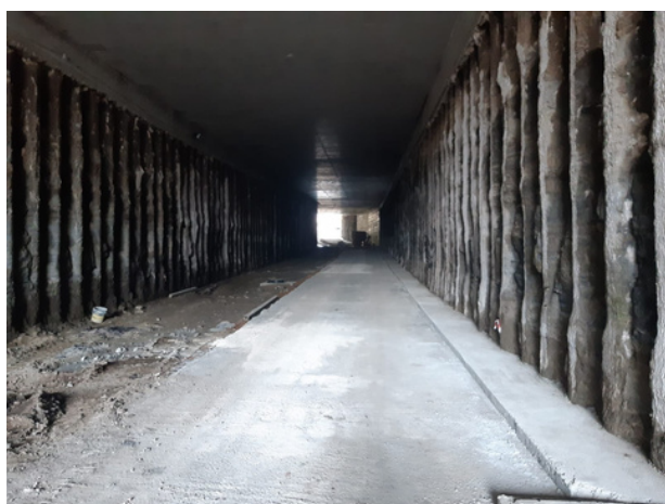
20 02 2023 preparazione soletta di collegamento
