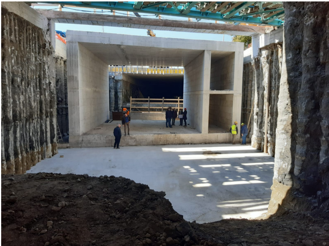
22 03 2022 ponte ferroviario provvisorio e ponte definitivo
